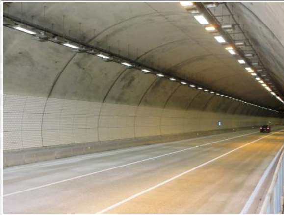
터널 내부 전경
