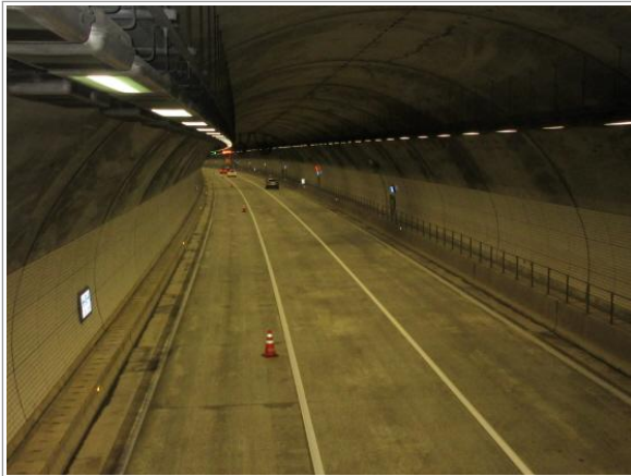
터널 내부 전경
