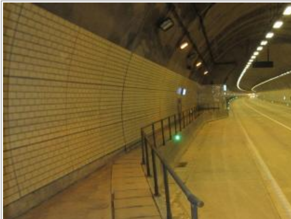
측벽부 타일마감 전경(주행선)
