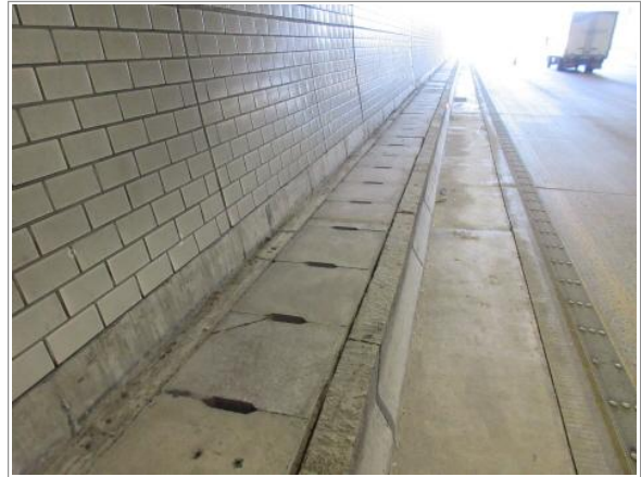
공동구 및 배수로 전경
