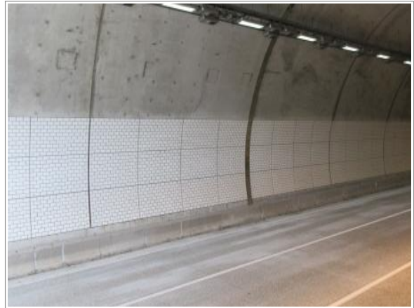
측벽부 타일마감 전경(추월선)
