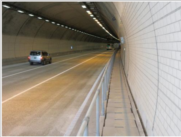
측벽부 타일마감 전경(주행선)
